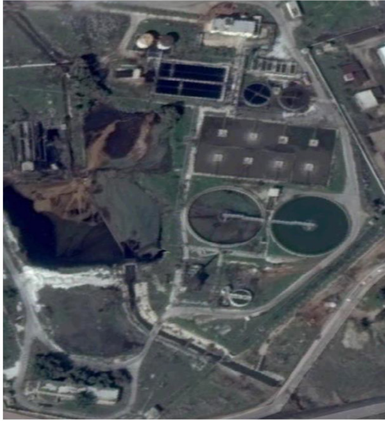
الشكل رقم (12): لقطة جوية لمحطة معالجة المياه الملوثة في مصفاة حمص
